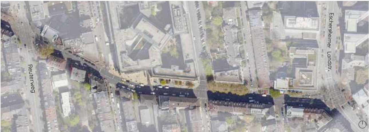
Abb.22: Luftbild - Bestandssituation Grüneburgweg "Abschnitt Ost"
