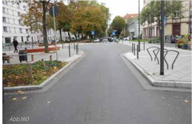
Foto 2: Gehwegnasen, Fahrbahnbreite in der Regel 3,50 m
